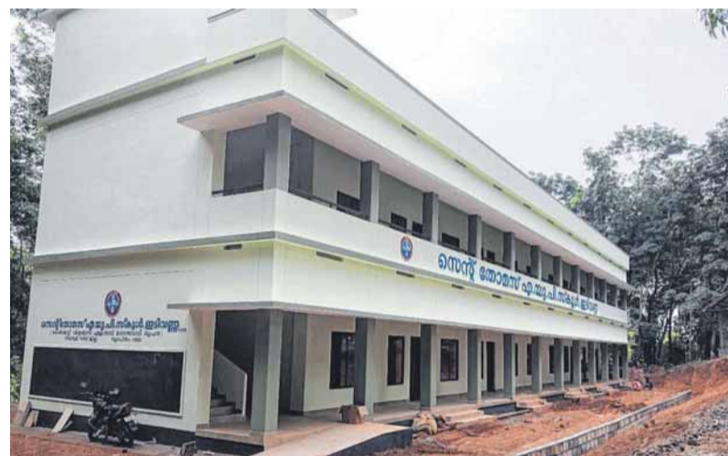
Für rund 90 000 Euro entstand in der Stadt Edivanna ein neues Schulgebäude. FOTO: PRIVAT
