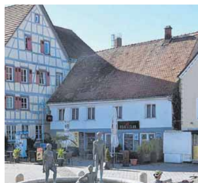
Das Haus am Marktplatz 14 in Bad Buchau soll abgerissen werden. ARCHIVFOTO: KLAUS WEISS
