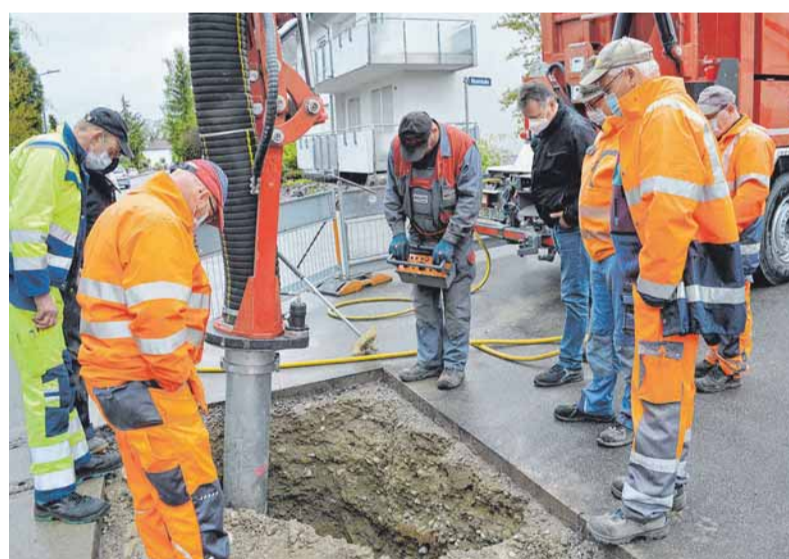
Interessiert beobachten die Bauhofmitarbeiter den Einsatz des Saugbaggers. FOTO: KLAUS WEISS
